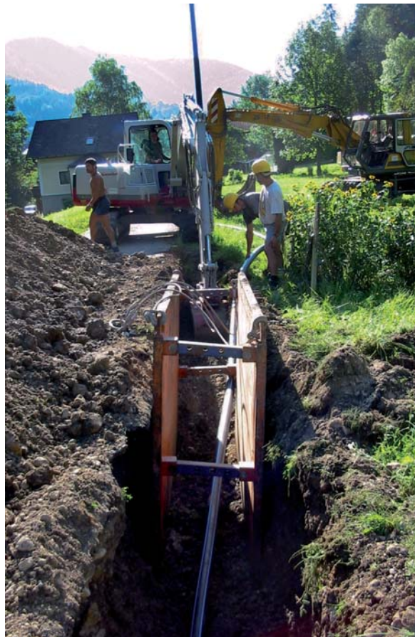
Der Wasserleitungsbau in Dürnbach bei Weyer. Heute gibt es rund 25 Kilometer Wasserleitungsleasing in der Gemeinde.
